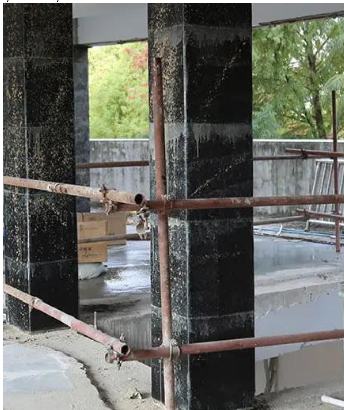
Рис. 41. Возведение железобетонной колонны из фибробетона на основе углеродного волокна
