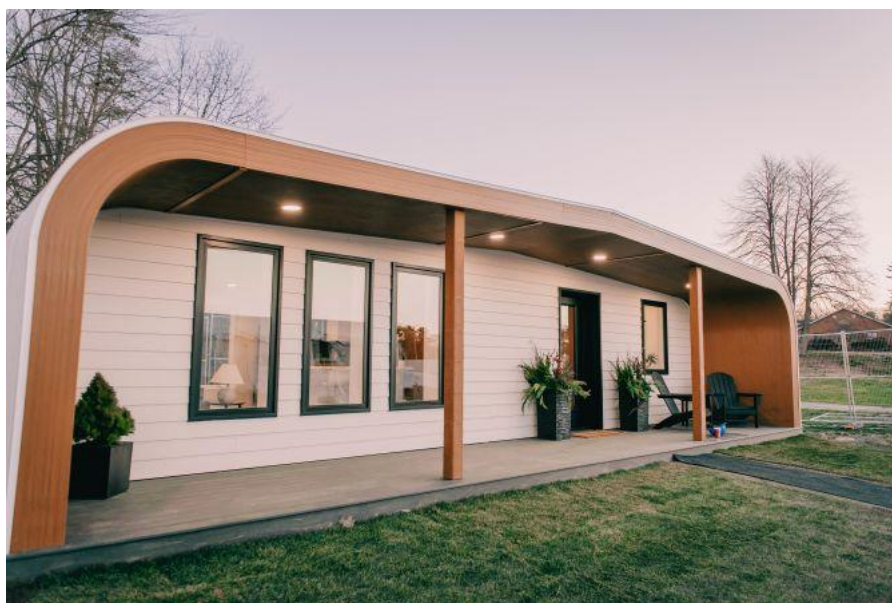
Рис. 35. BioHome3D - деревянный дом созданный с 3DP
